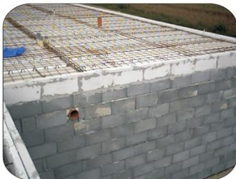
Na panely se uloží armovací síť KARI. Z důvodu požární odolnosti stropní konstrukce je na panely standardně pokládána síť Kari 4/200.
