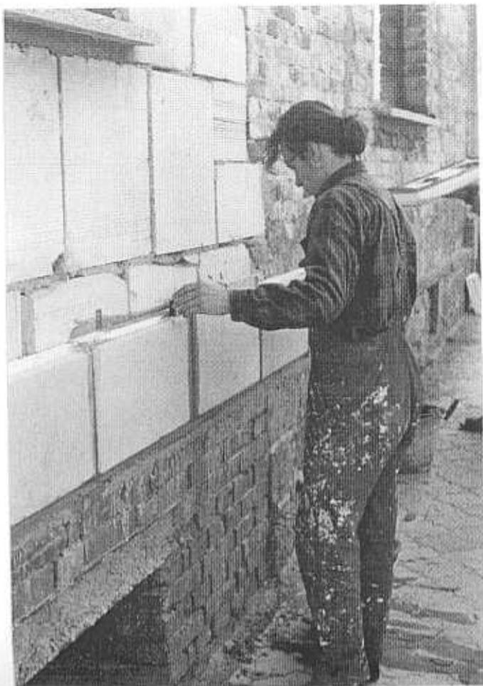
9/Kontrola roviny 1. řady, určující pro celý obklad
