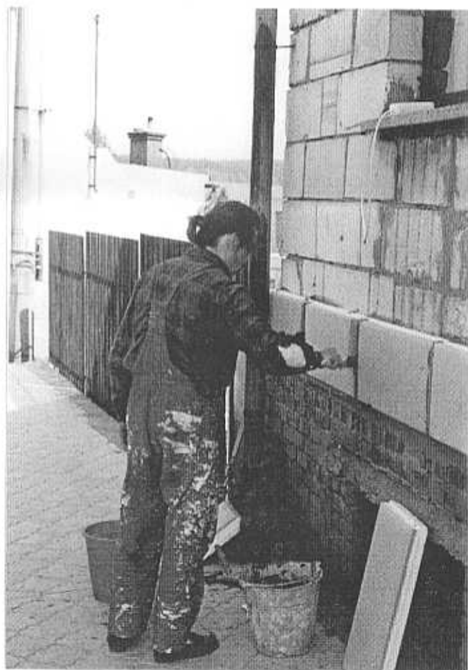
10/Rozetření "vymačklého" lepidla 11/ve spárách vlhkým štětcem
