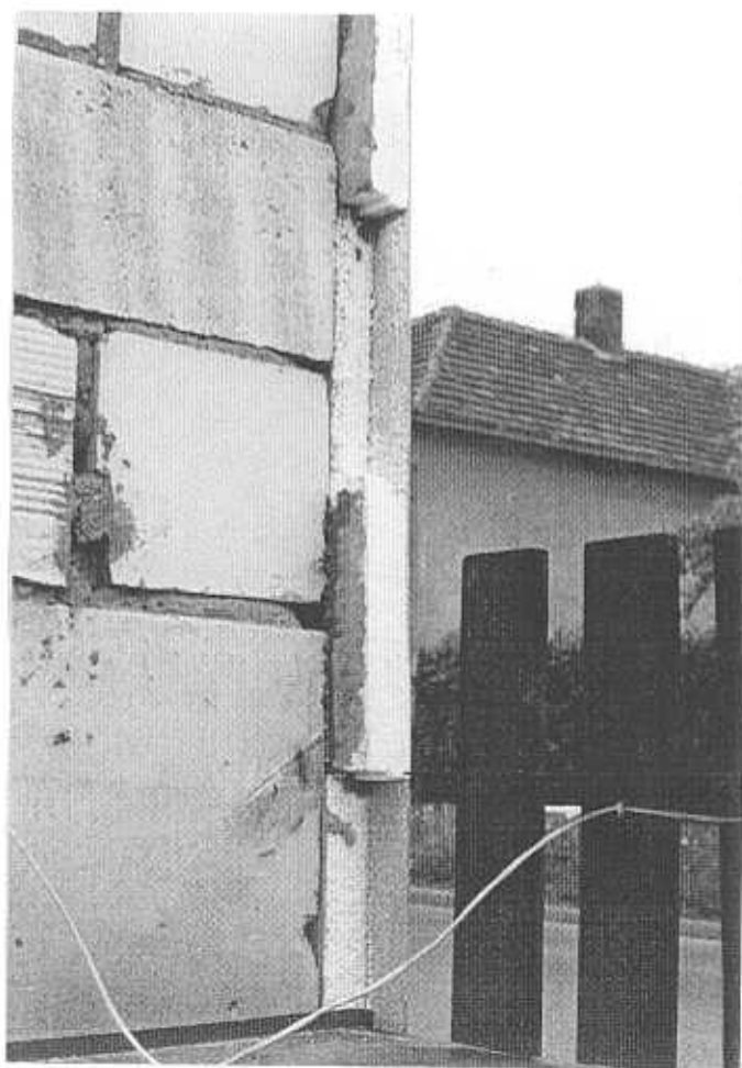
25/Řešení provázání nároží pokud s obkladem pokračujeme za rohem
