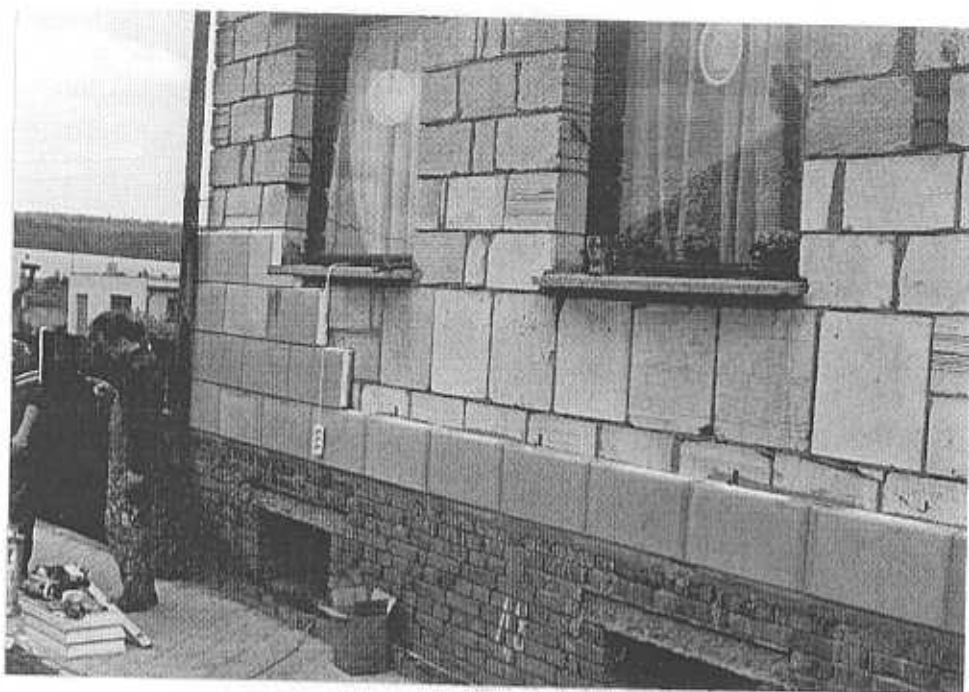
24/Dokončení 1. řady a založení rohu a okna "
