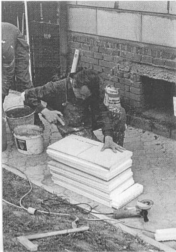
21/Dořiznutí izolantu zednickou lžící
