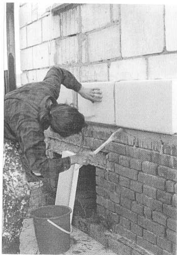
10/Rozetření "vymačklého" lepidla 11/ve spárách vlhkým štětcem
