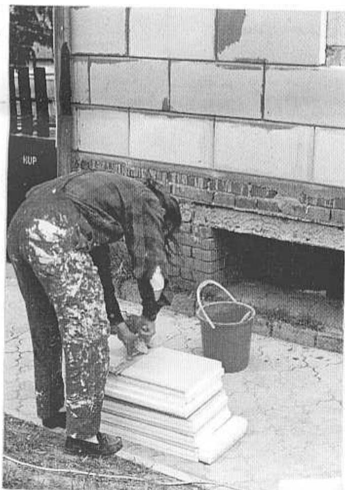
19/Dělení kazety BLOK oprá- vání tvaru (např. k usazení pod parapet)
