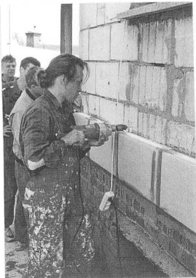
14/Upevnění "příchytěk", vždy nad každou druhou deskou ke straně /stykování horní řady je na středu spodní desky/
